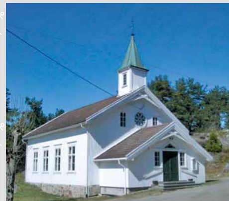
Justøy kapell Brekkestøveien, 4780 Brekkestø
